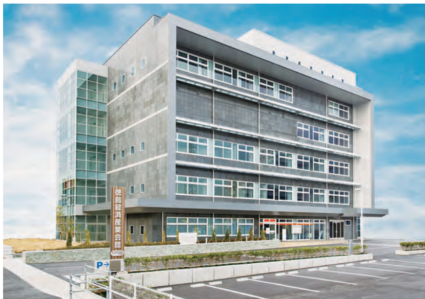
事務所建物外観
