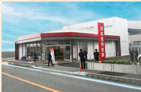
徳島信用金庫 佐古支店 店舗外観
